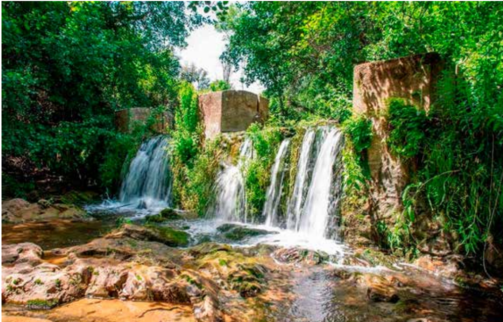
Toma de agua del Molino de Los Frailes.
